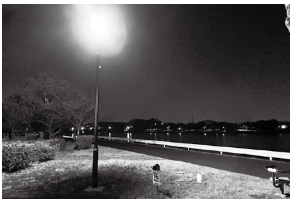
◎公園照明灯のLED化
