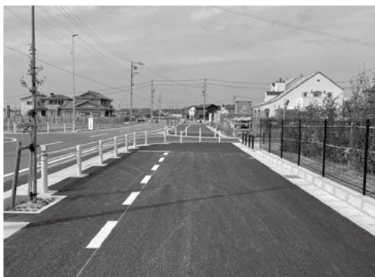
◎歩道内自転車通行空間
