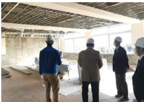
南中学校の工事現場
