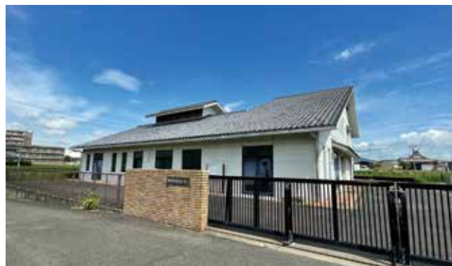
福谷浄化センター
