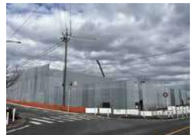
令和7年秋の開館を目指して 工事が進む（仮称）みなよし地区 拠点施設
