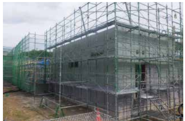
城山保育園移転新築工事状況(令和7年5月末時点)
