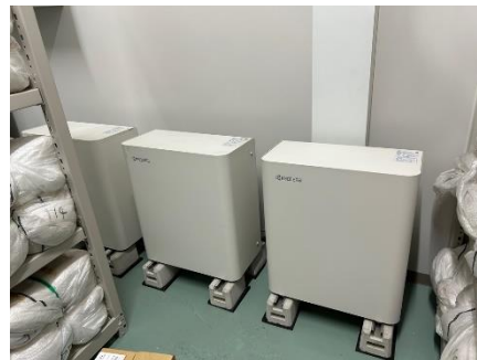
拠点防災備蓄倉庫
