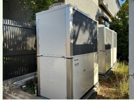
三好公園総合体育館
