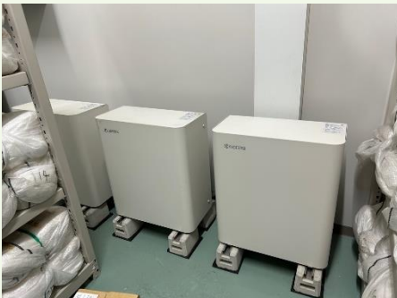
拠点防災備蓄倉庫
