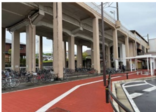
三好ヶ丘駅駐輪場
