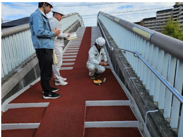
令和7年度 工事検査補助業務委託(土木)(旭橋)実施状況
