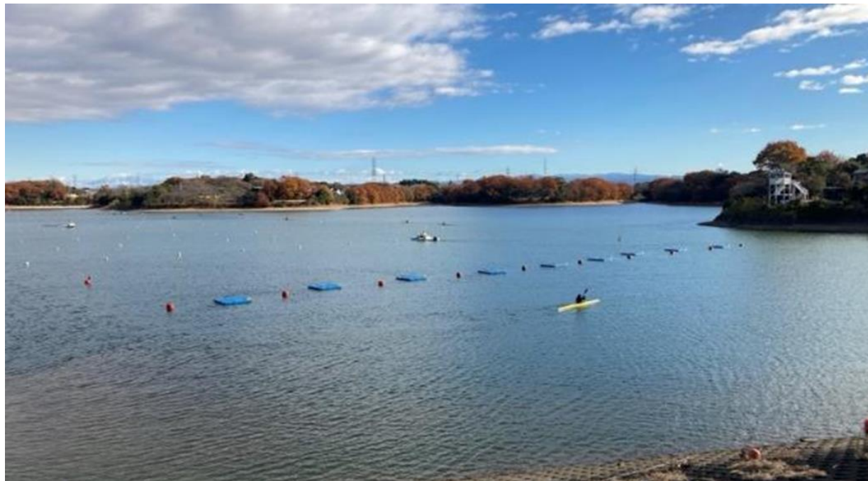
愛知用水の調整池である三好池
