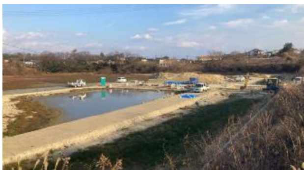
県営防災ダム事業による四井池の耐震工事
