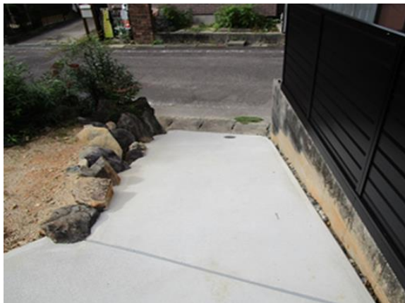
高嶺公民館 スロープ手すり設置工事
