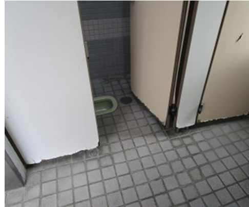
明知下公民館 外トイレ扉・間仕切り修繕工事
