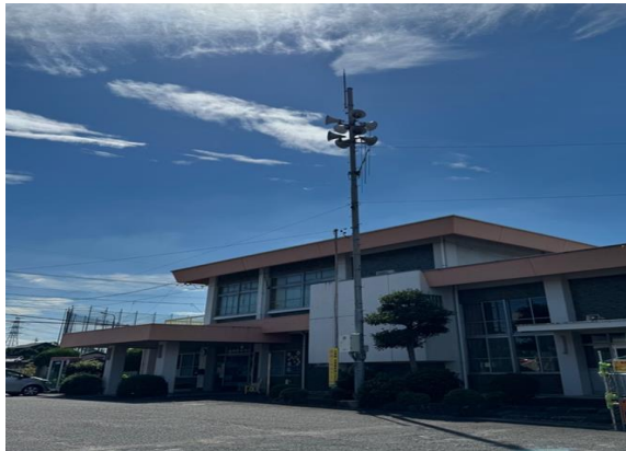
明知上公民館 防犯カメラ設置工事
