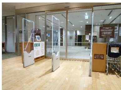
セキュリティゲート(中央図書館2階)
