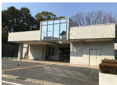
(障がい者福祉センター 外観)
