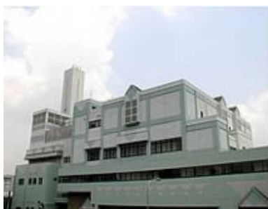
焼却施設外観
