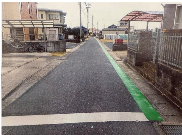
安全のみどり線修繕後
