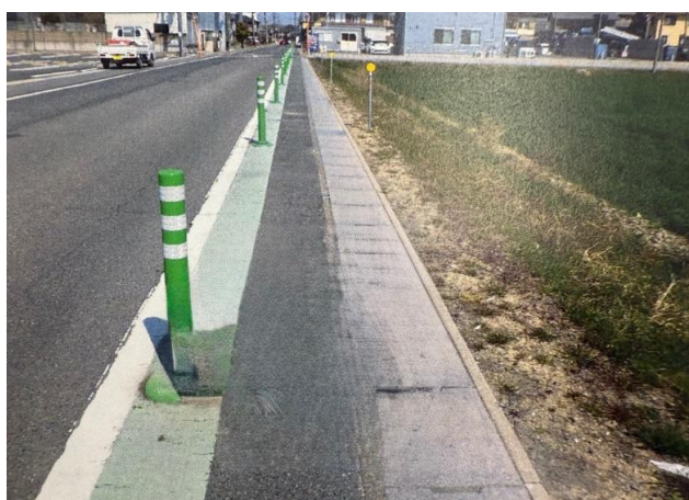
ラバーポール修繕後
