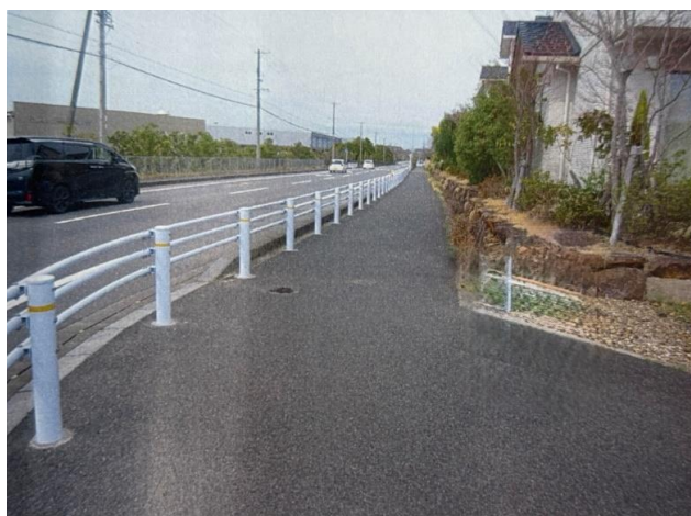
防護柵等設置後
