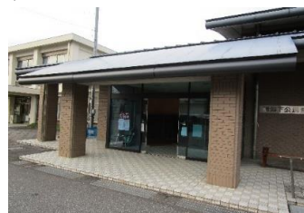
入口上庇修繕工事(明知下行政区)
