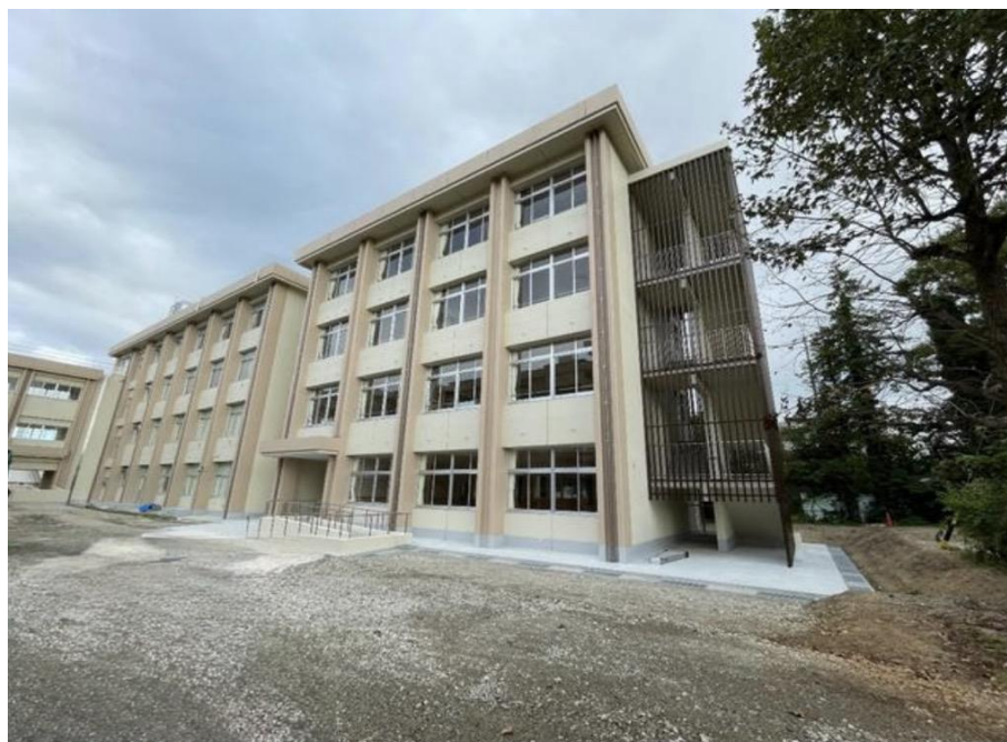
南中学校大規模改修(2期)工事 特別教室棟増築部外観
