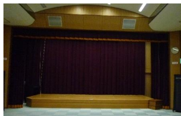
緞帳撤去工事(明知上行政区)
