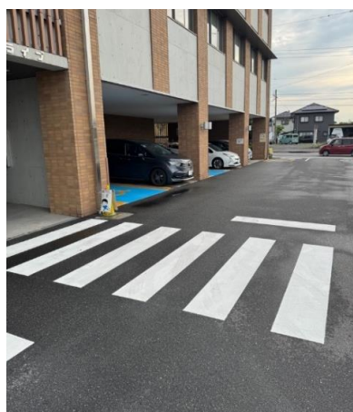
駐車場塗替え修繕②
