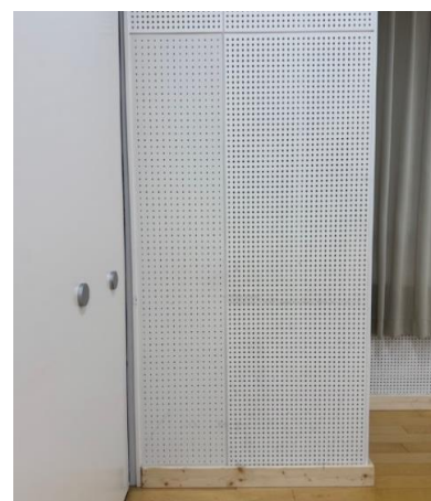
講座室兼音楽室内壁修繕
