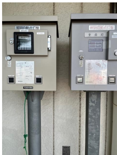
旭グラウンド照明設備コインタイマー盤修繕工事
