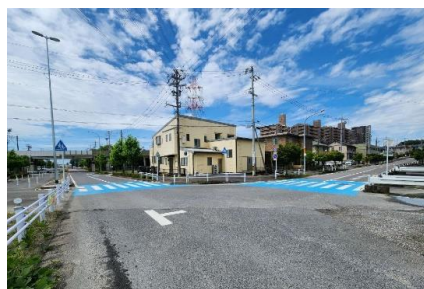
《三好丘あおば横断歩道設置対策工事》
