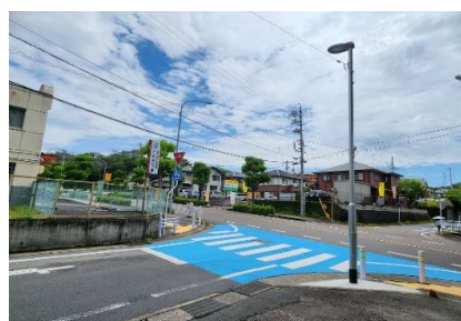
《三好丘交番横断歩道設置対策工事》
