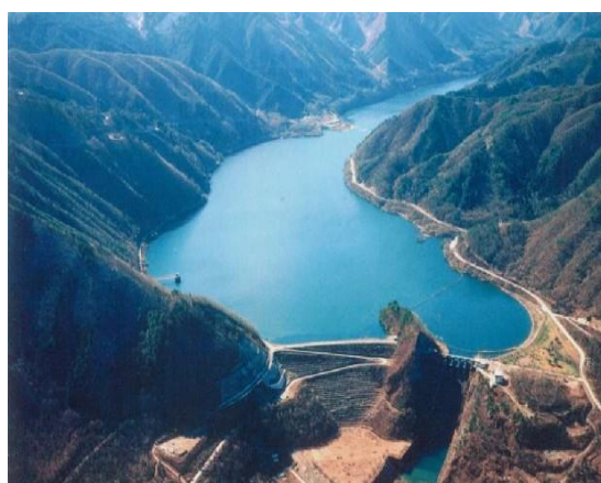
【牧尾ダム全景】
