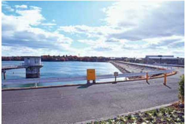
三好池堤防と取水塔
