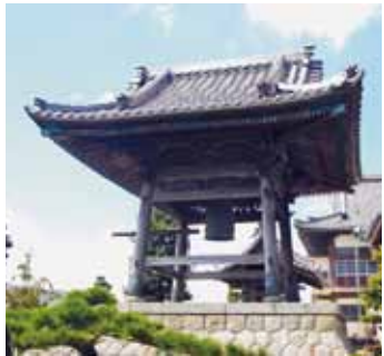
戦時中コンクリート製の釣鐘が掛けられていた鐘楼
