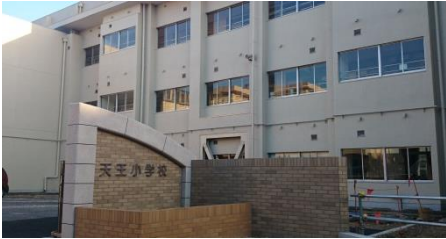
市内各校の校舎の建設・改修の状況
