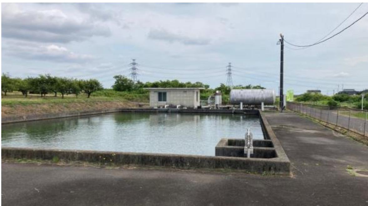
ポンプ場(明知上第二用水機場)
