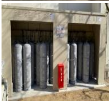
←【空調機用容器倉庫】
