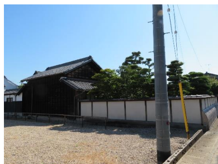
外塀(白い塀)から主屋(座敷)
