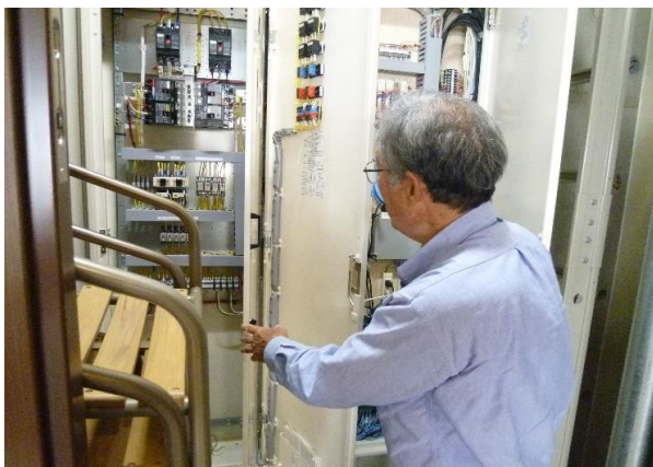
サンライズ建物設備の点検作業
